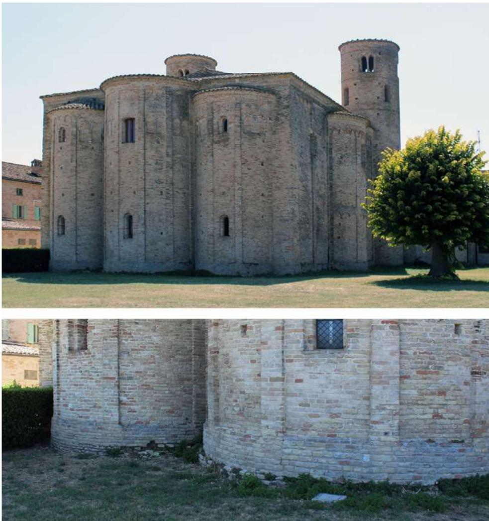
Fig. 6. Panoramica della zona absidale della chiesa di San Claudio, area degli scavi del 1980-82, con particolare del piede di due absidi, impostate su resti di edificio d'età precedente (foto Autore 2025).
