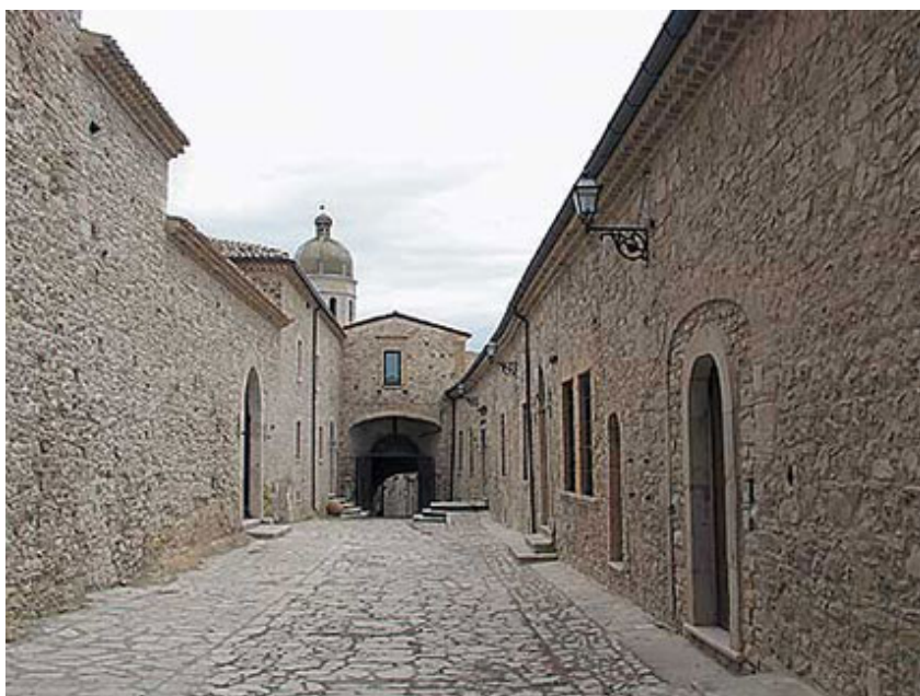
Fig. 8. Cortile del Palazzo Ducale di Pietramontecorvino
