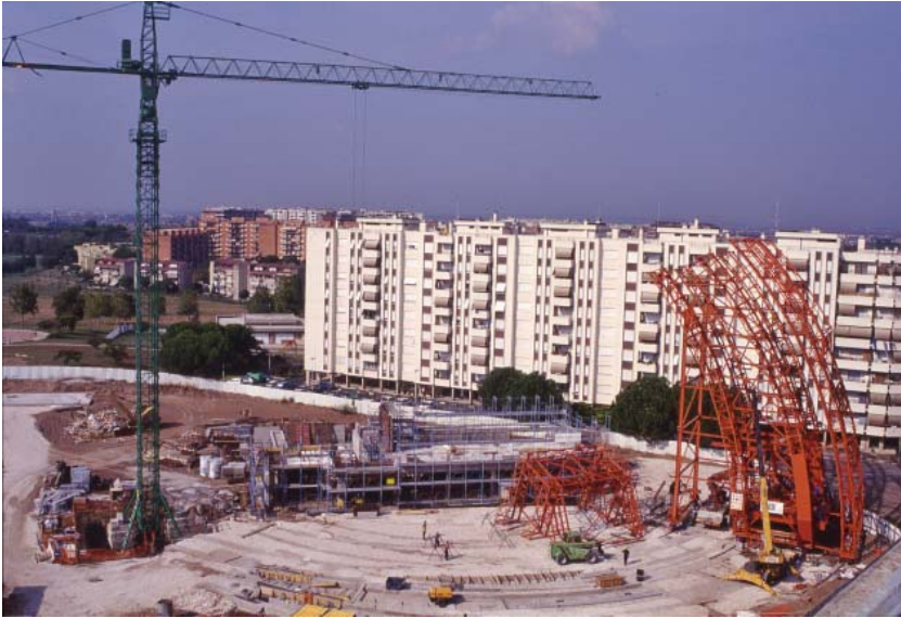
Fig. 6. Roma, Tor Tre Teste, la fase iniziale del cantiere della chiesa di Dio Padre Misericordioso
