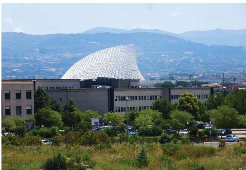
Fig. 5. Roma, Tor Vergata, il cantiere interrotto del palazzo dello sport di Santiago Calatrava, sullo sfondo i Castelli Romani
