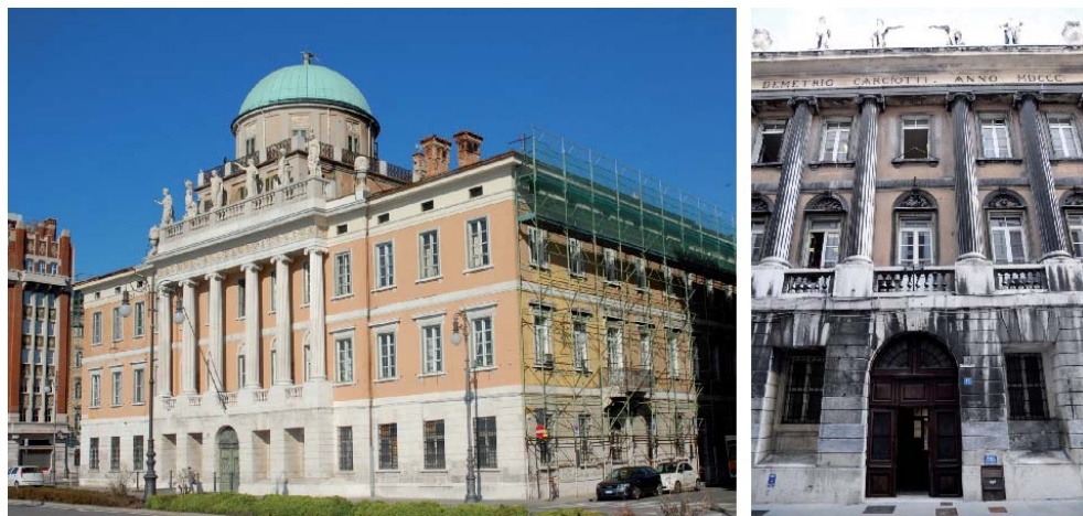
Fig. 20-21. Palazzo Carciotti: facciata frontale e facciata postica
