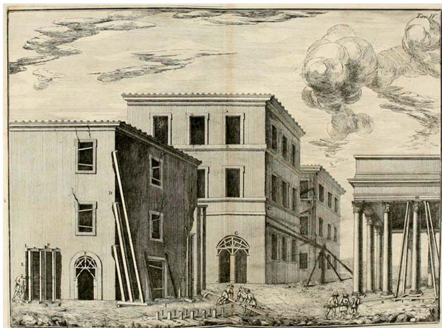
Fig. 17. Masi 1788, Puntellature e rifondazione di una colonna
