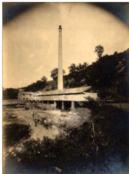
Fig. 18. Veduta generale della fornace di laterizi Di Re in una foto dell'epoca (Collezione privata Di Re)
