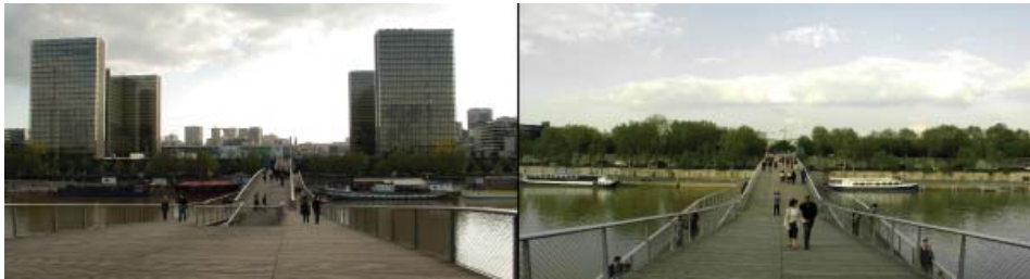
Fig. 3. La passerella Simone de Beauvoir , vista dalla Rive-Gauche e da Bercy, Parigi (Foto di T. Taddei)
