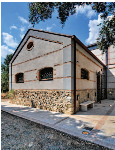
Fig. 21. Uno dei corpi laterali restaurato
