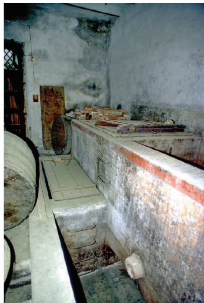
Fig. 7. Lo stato dell'edificio del Frantoio Nesci prima del restauro, interni
