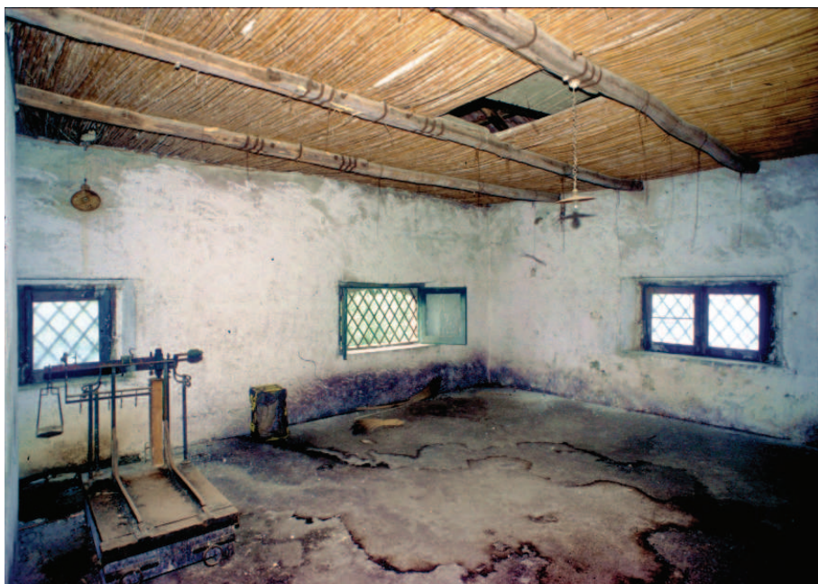
Fig. 9. Lo stato dell'edificio del Frantoio Nesci prima del restauro, interni
