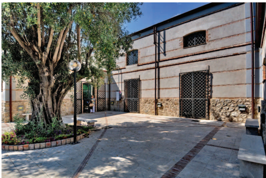
Fig. 20. La piazzetta esterna dopo il restauro
