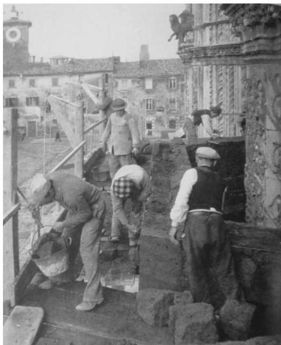
Fig. 3. Operai al lavoro per il blindamento della facciata del duomo (da Testa 1990)
