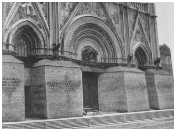
Fig. 4. Blindamento della parte basamentale della facciata del duomo (da Testa 1990)
