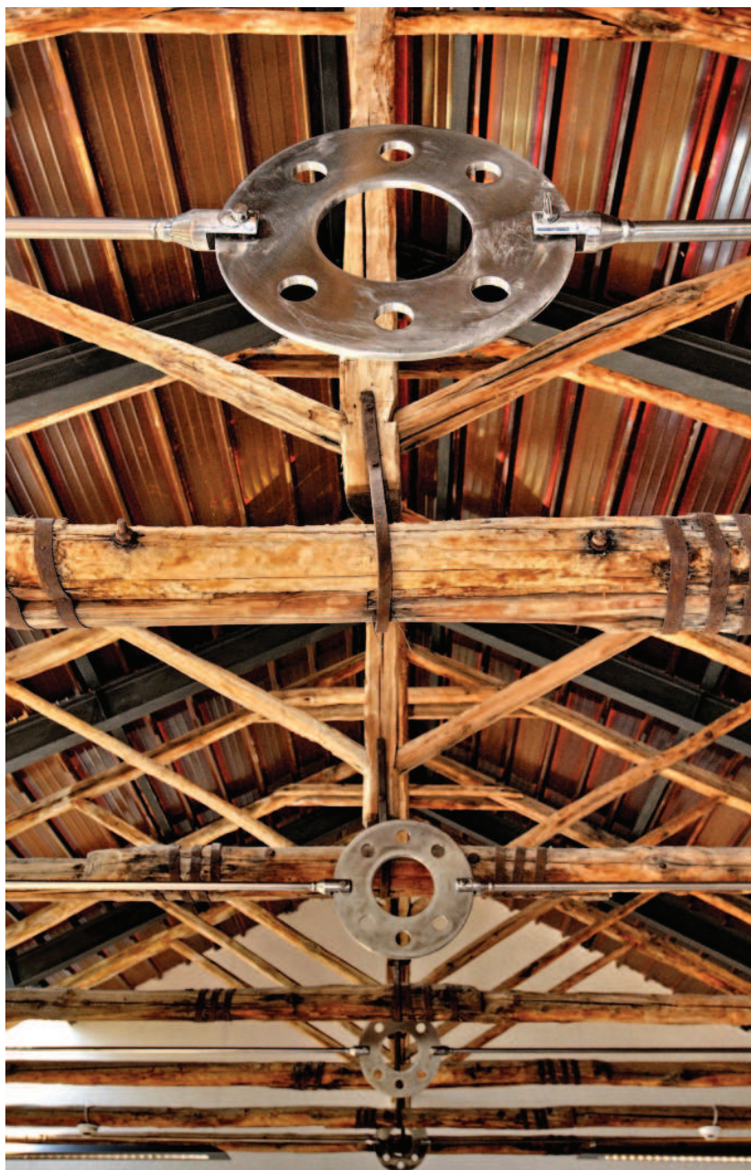
Fig. 26. Le nuove strutture di consolidamento del tetto
