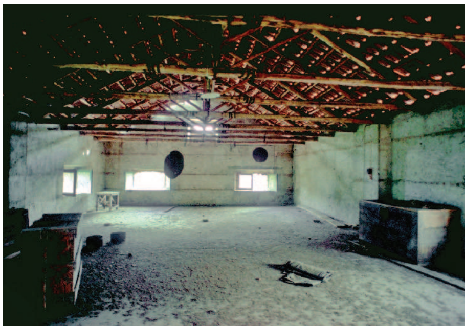
Fig. 8. Lo stato dell'edificio del Frantoio Nesci prima del restauro, interni
