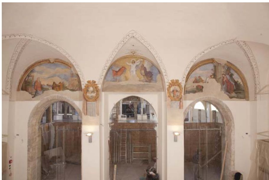
Fig. 7. Le decorazioni parietali dopo gli interventi di scopertura e successivo restauro (Foto dell'autore)
