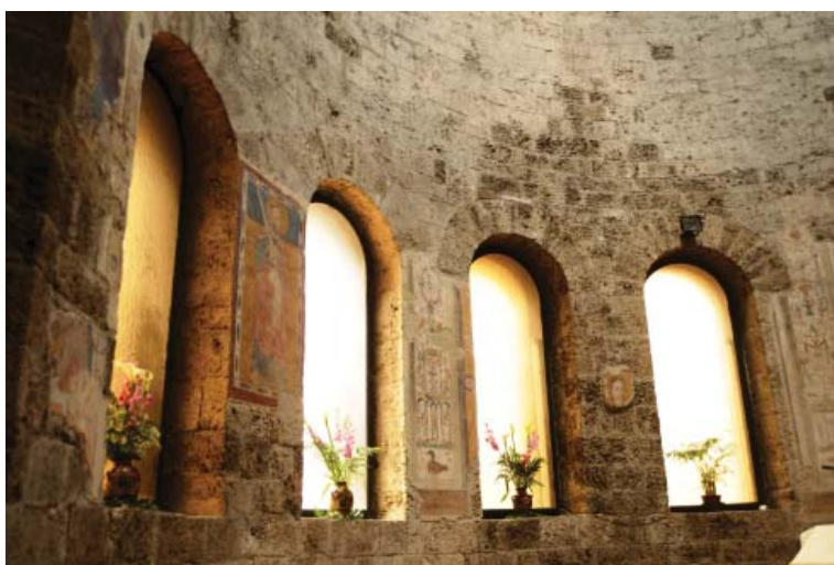
Fig. 6. Terni, S. Salvatore, finestre ad arcata della rotonda
