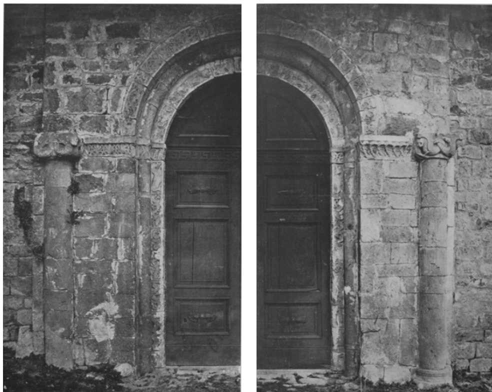
Figg. 5-6. Capo di Ponte (BS), pieve di San Siro, particolare del portale nello stato precedente al restauro, lato sinistro e lato destro (da Canevali 1912)
