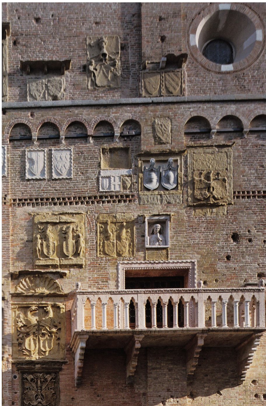
Fig. 3. Parete occidentale del Salone, particolare dello zoccolo in pietra che segna il coronamento dell'edificio duecentesco (foto Autore)
