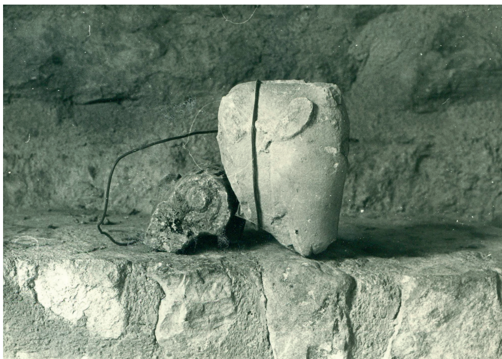
Fig. 10a-b. 10a: Terzo pilastro a partire dalla controfacciata nel quale è stato reimpiegato il capitello oggi nella cripta; 10b: Voluta e protome bovina, dalla campagna di restauro condotta fra il 1984 e il 1985 (L'Aquila, Soprintendenza Archeologia Belle Arti e Paesaggio per le province di L'Aquila e Teramo, Archivio fotografico, negativi nn. 21720 e n. 21728 © Soprintendenza Archeologia, Belle arti e paesaggio per le province di L'Aquila e Teramo)
