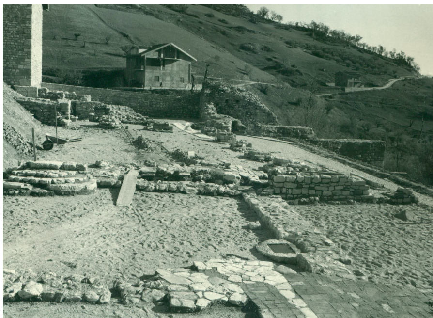
Fig. 12a-b. Carpineto della Nora (PE), complesso monastico di S. Bartolomeo, 12a: Prospetto meridionale con torrione, i resti del portico a due livelli e gli avanzi dell'organismo claustrale (anni Trenta); 12b: Area claustrale fatta riemergere nell'ambito della campagna di scavo degli anni Ottanta (negativi nn. 34309A e 26237 © Soprintendenza Archeologia, Belle arti e paesaggio per le province di L'Aquila e Teramo)
