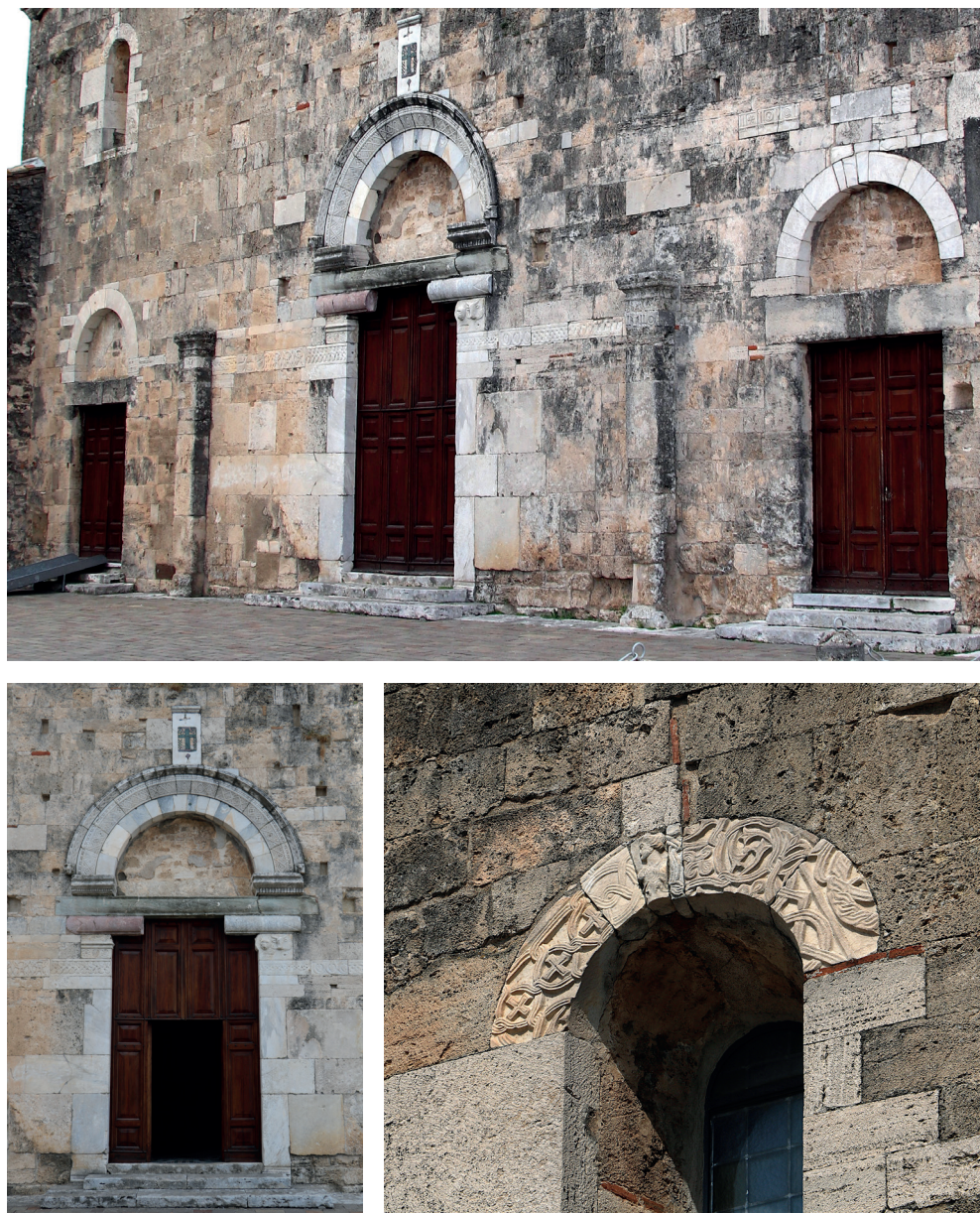
Fig. 12. Anagni, cattedrale di S. Maria: a) facciata, particolare; b) portale centrale; c) monofora sinistra in facciata (Creative Commons)
