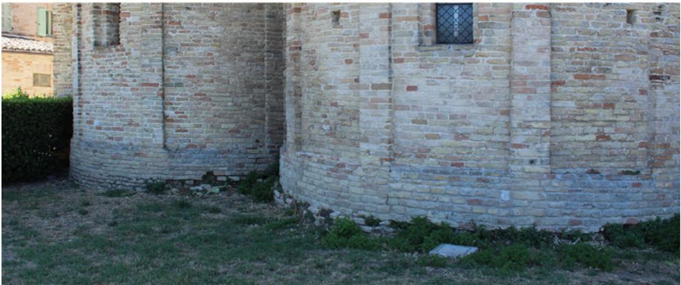
Fig. 6. Panoramica della zona absidale della chiesa di San Claudio, area degli scavi del 1980-82, con particolare del piede di due absidi, impostate su resti di edificio d'età precedente (foto Autore 2025).
