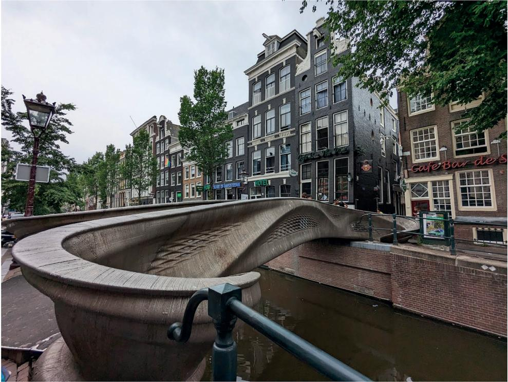
Fig. 9. Joris Laarman e MX3D, *MX3D Bridge a Amsterdam*, ponte pedonale in acciaio inossidabile realizzato in manifattura additiva con stampante 3D robotizzata, 2018-2023
