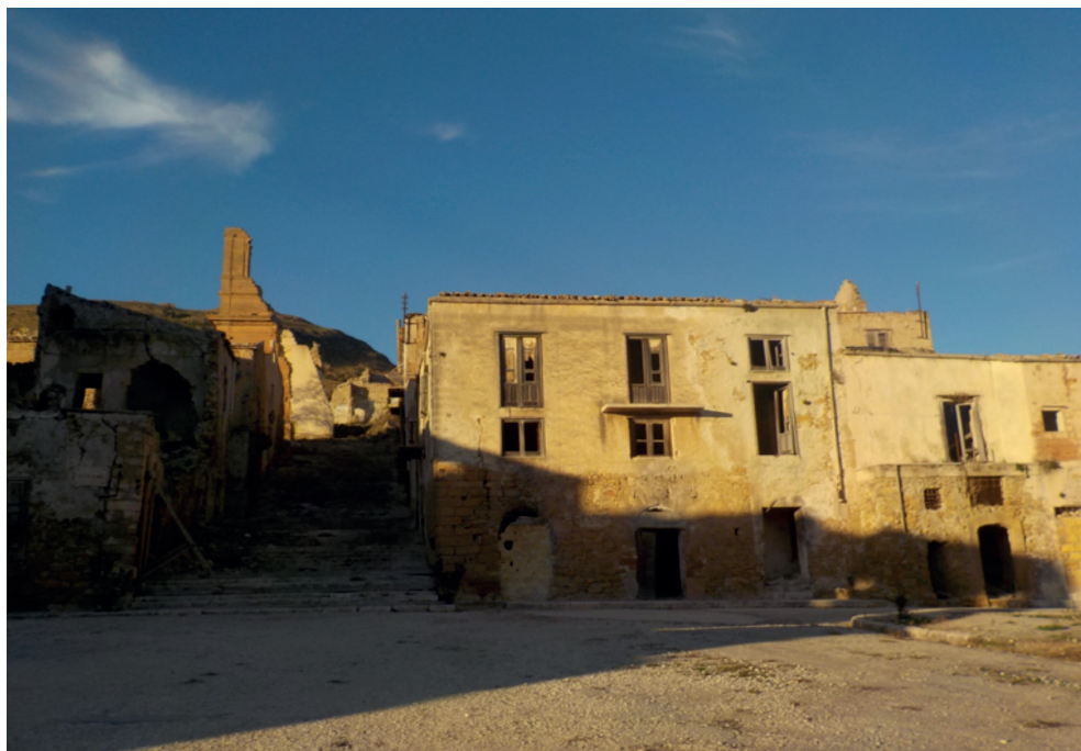
Fig. 6. La piazza i resti della Torre dell'Orologio nella ghost town di Poggioreale, set location de L'uomo delle Stelle (1995) e Malèna (2000) di Giuseppe Tornatore. Fotografia di Enrico Nicosia
