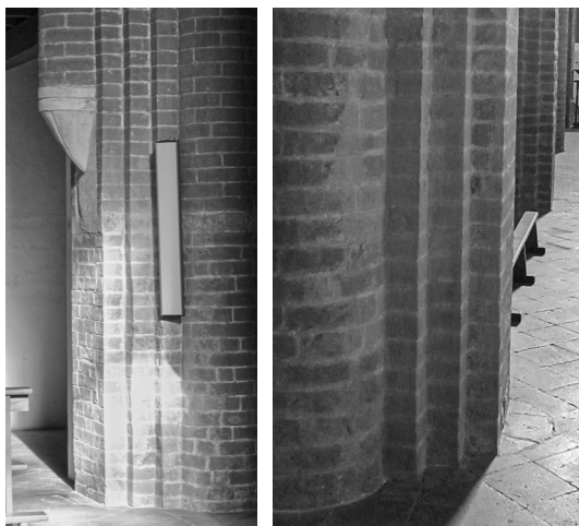
Figg. 8a-b - Chiesa di Chiaravalle della Colomba, navata centrale, lato S, 3° pilastro forte e traccia semicircolare del 3° pilastro debole.
