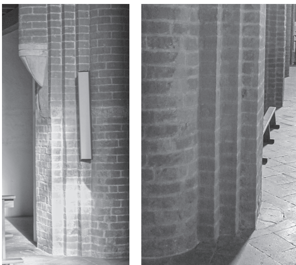
Fig. 8a-b. Chiesa di Chiaravalle della Colomba, navata centrale, lato S, 3° pilastro forte e traccia semicircolare del 3° pilastro debole
