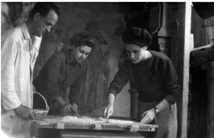
Fig. 4. Viterbo, chiesa di Santa Maria della Verità, Cappella Mazzatosta, Carlo Matteucci, Anna Maria Sorace e Laura Mora stuccano i frammenti crollati ricomposti su supporto mobile (foto 1948 ca., proprietà Simone Colalucci)
