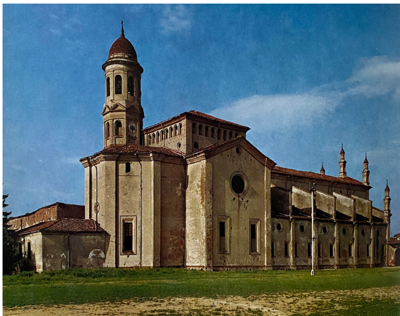
Fig. 7. Veduta esterna sul fianco e sull'abside, Cremona, chiesa di San Sigismondo
