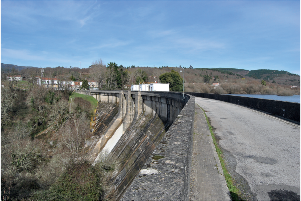
Fig. 5. Presa del embalse de As Conchas. Vista general. (Foto B. Fernández)
