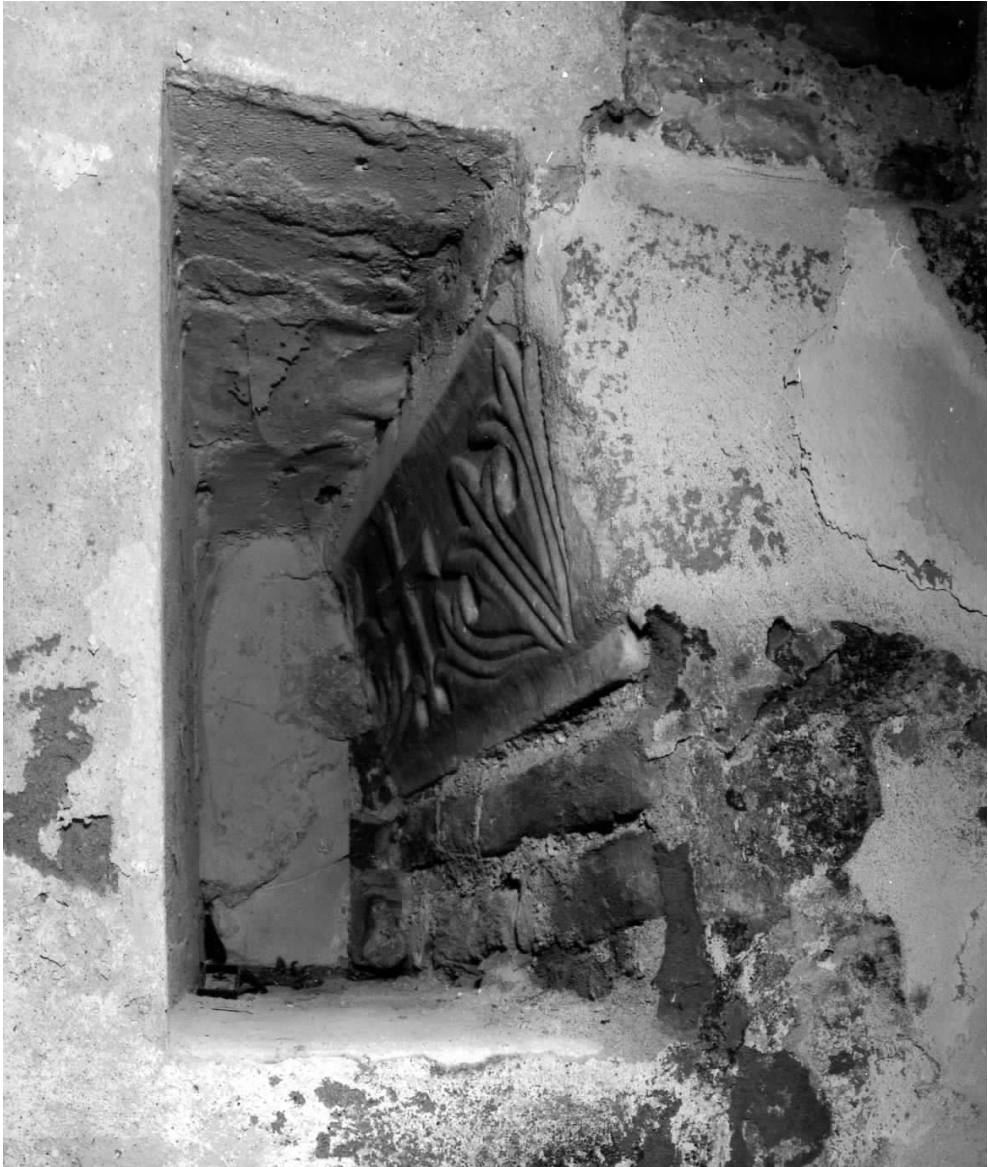
Fig. 10. Pulvino in opera nelle murature della navata centrale della chiesa di S. Andrea Maggiore come si presentavano negli anni '70 del Novecento (BCR, Fondo Fotografico Mazzotti , n. 2885A)
