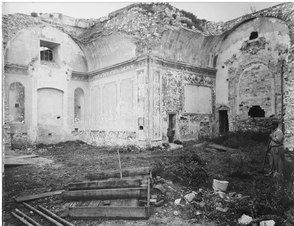
Fig. 12. Numana, già chiesa del Santissimo Crocifisso in demolizione
