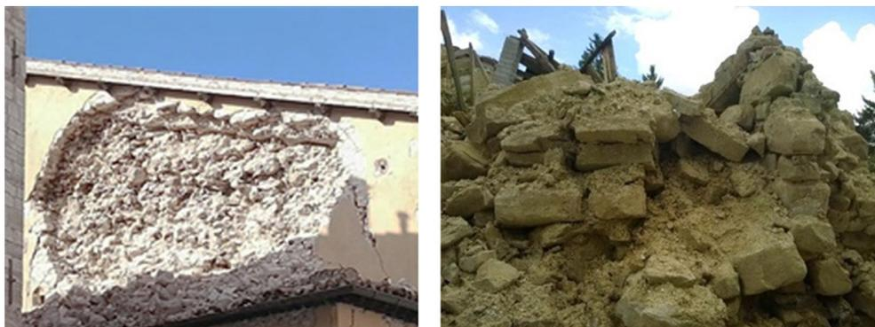
Fig. 2a-2b. Disgregazione delle murature di qualità scadente, costituite da ciottoli e da malte molto povere
