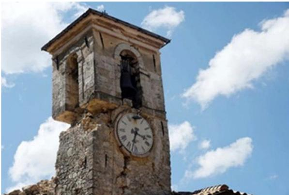
Fig. 7. Rottura della cella campanaria
