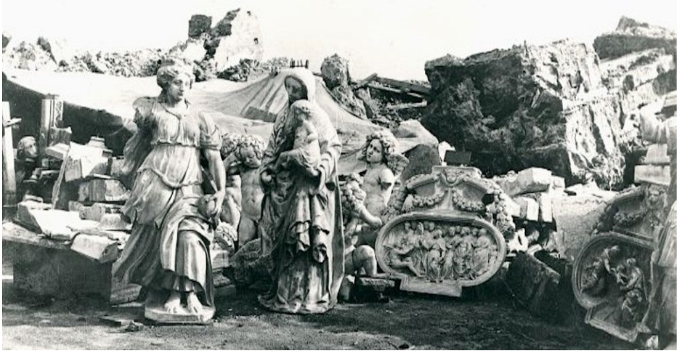
Fig. 11. Messina, recupero delle opere dopo il terremoto del 1908
