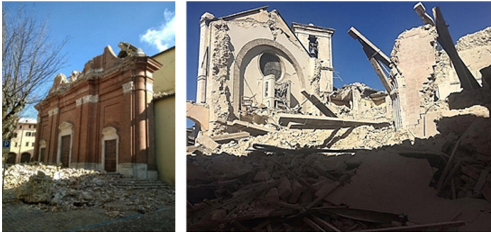
Fig. 6a. Ribaltamento del timpano di una chiesa a Camerino; 6b. Ribaltamento delle pareti laterali della cattedrale di Norcia
