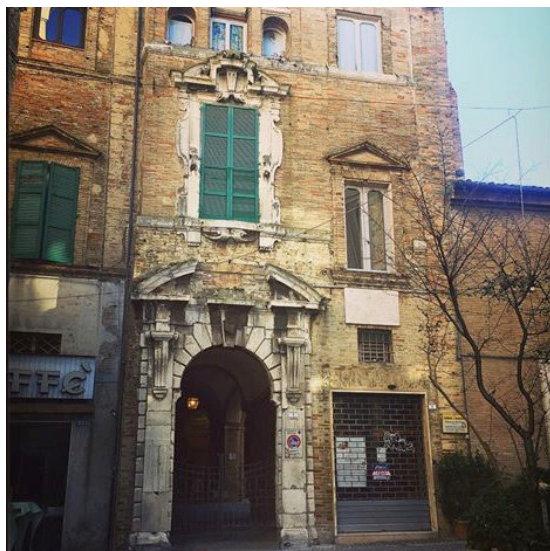
Fig. 1. Macerata, palazzo De Vico, facciata
