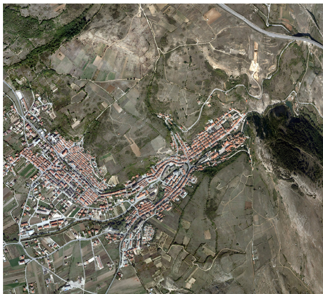
Fig. 4. Visione aerea di Pescina (ortofoto 2009). Si notano i progressivi ampliamenti dell'abitato. A quota maggiore la parte vecchia abbandonata (tra il castello e la chiesa di San Berardo), più in basso il centro storico e gli edifici ricostruiti dopo il sisma del 1915, infine lo sbocco nella piana del Fucino
