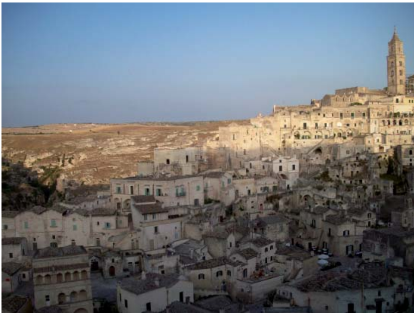
Fig. 19. Veduta panoramica della città di Matera: in primo piano il Sasso Barisano, in secondo piano la Civita e sullo sfondo la gravina
