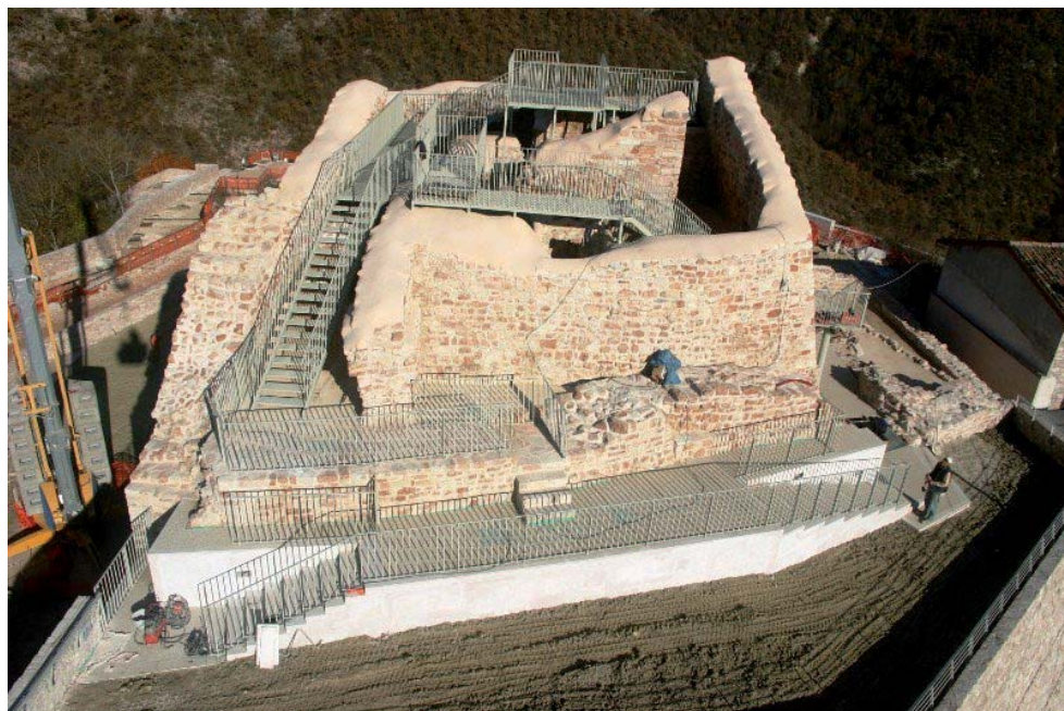
Fig. 2. Il castello di Mevale di Visso, Lavori di consolidamento
