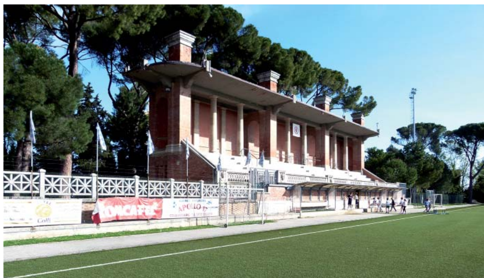
Fig. 22. Campo Sportivo della Vittoria, tribune, stato attuale, immagine del fronte sud
