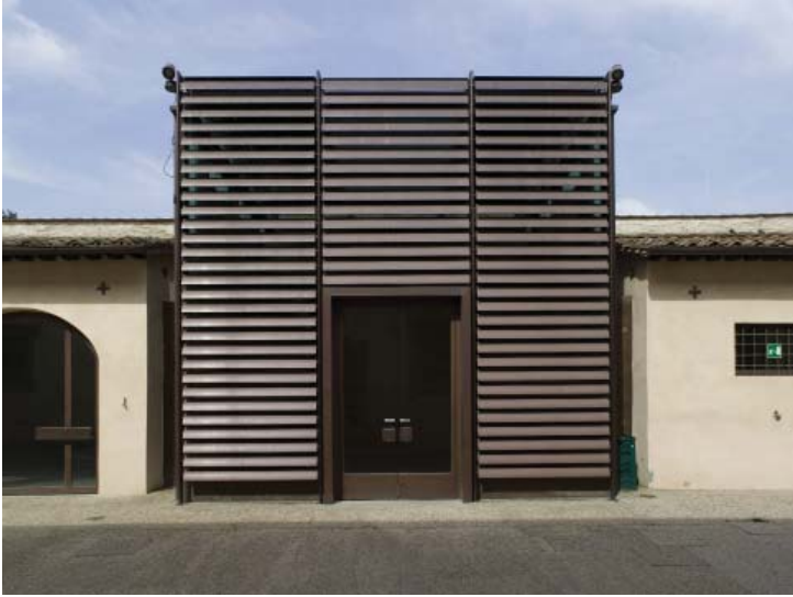
Fig. 3. Il volume vetrato con i brise-soleil in rame, hall di ingresso all'area ristoro e "contenitore" dei servizi e degli impianti tecnologici
