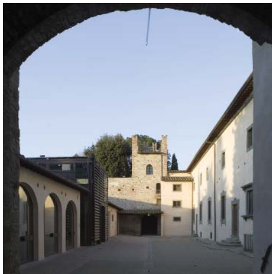
Fig. 4. Vista della corte dall'ingresso principale posto in corrispondenza della torre nord
