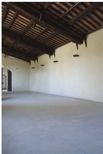
Fig. 8. L'interno della Sala dei vasi
