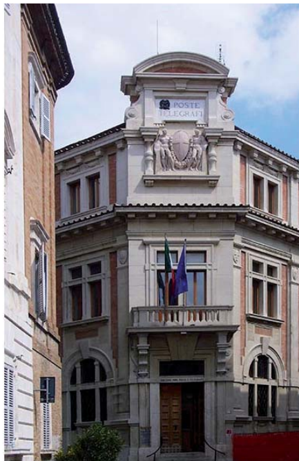
Fig. 1. Macerata, Palazzo delle Poste, immagine dello stato attuale
