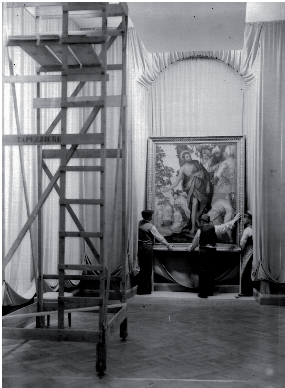
Fig. 10. "Mostra di Veronese" (1939). Operazioni di allestimento della Predica del Battista dalla Galleria Borghese di Roma, Comune di Venezia - Archivio della Comunicazione (Foto: Reale Fotografia Giacomelli)
