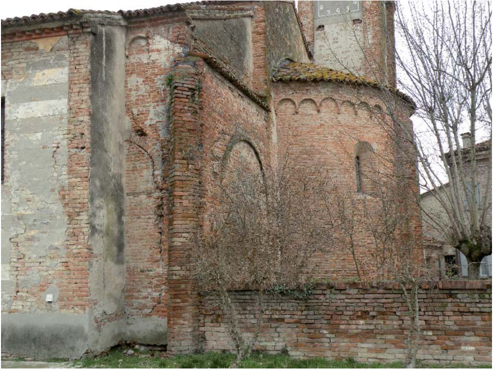
Fig. 14. Nuvolato, S. Fiorentino, l'esterno da sud-est
