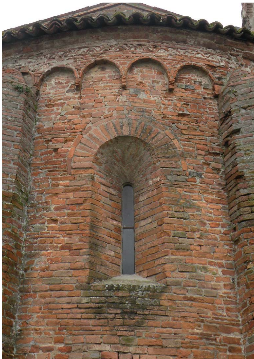
Fig. 16. Nuvolato, S. Fiorentino, abside, particolare della monofora centrale
