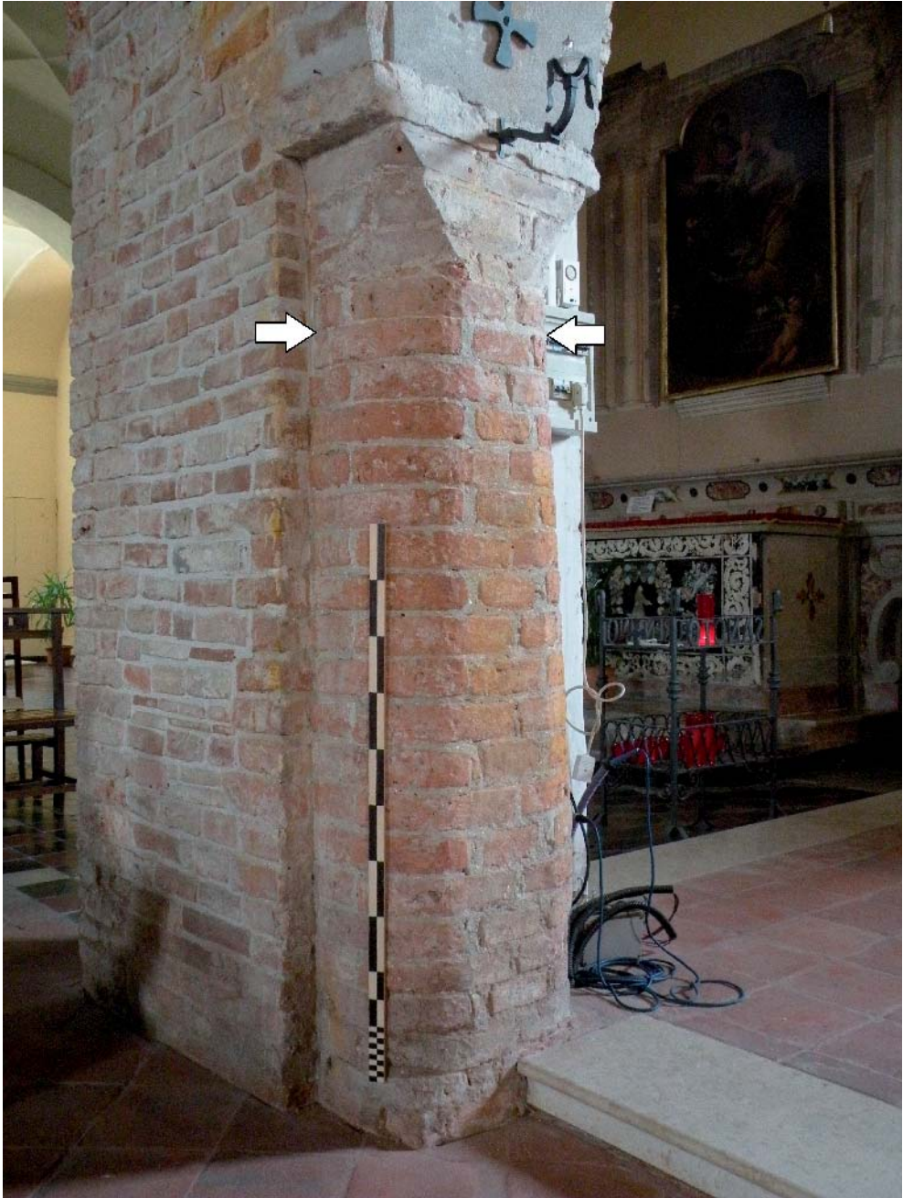
Fig. 9. Nuvolato, S. Fiorentino, semicolonna di nord-ovest. Le frecce indicano il punto in cui compare il nuovo tipo di malta
