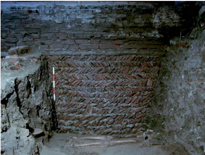
Fig. 12. Nuvolato, S. Fiorentino, parete sud della navata, muro di fondazione della chiesa romanica (fase 2, attività 1), (Per gentile concessione della Soprintendenza Archeologica della Lombardia)
