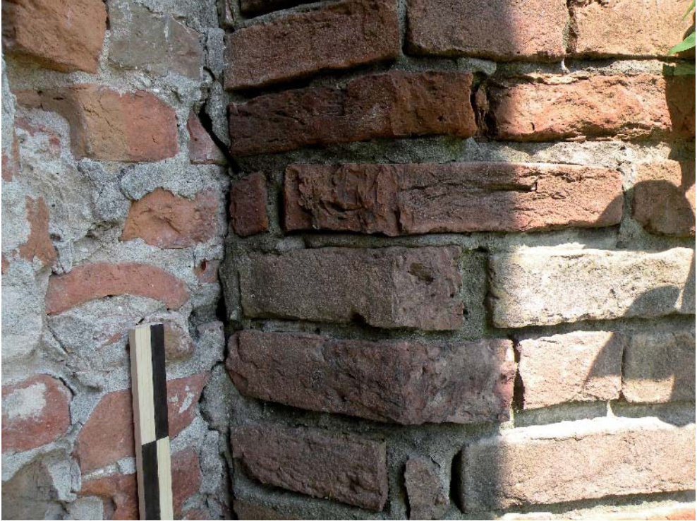
Fig. 21. Nuvolato, S. Fiorentino, transetto sud, particolare del contrafforte orientale (vedi figura 8, in verde)
