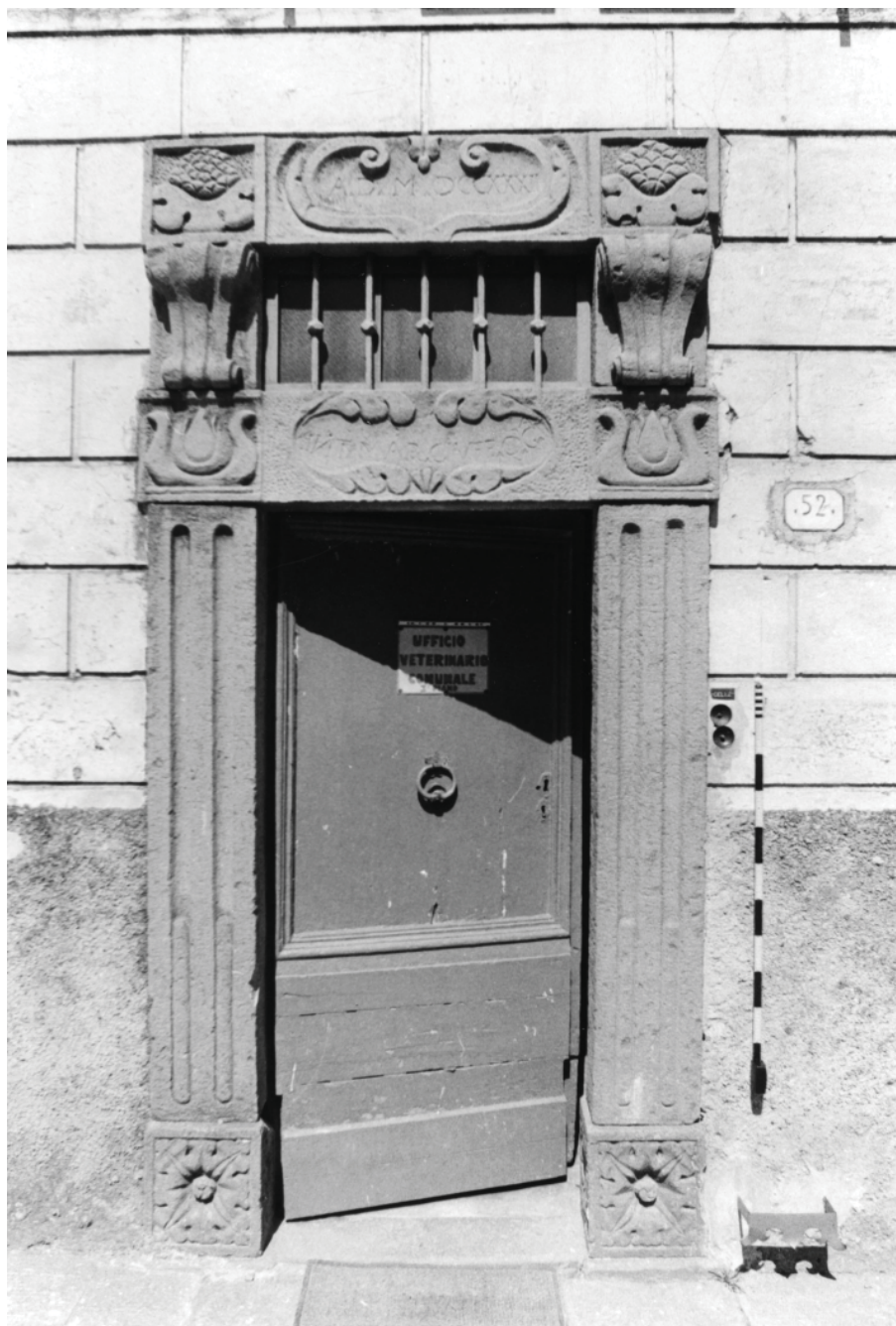
Fig. 6. Portale architravato con sopraluce anch'esso architravato e datato 1732 a Riccò del Golfo (La Spezia)
