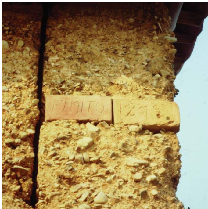
Fig. 13. Scritta «FINITO 1879» incisa sui mattoni inseriti nell'angolo del muro di terra di un cascino (cascinòt) sito in località Zerba-Lobbi (Alessandria). È l'ultimo episodio di un accrescimento dell'edificio avvenuto con quattro interventi tutti datati da mattoni graffiti
