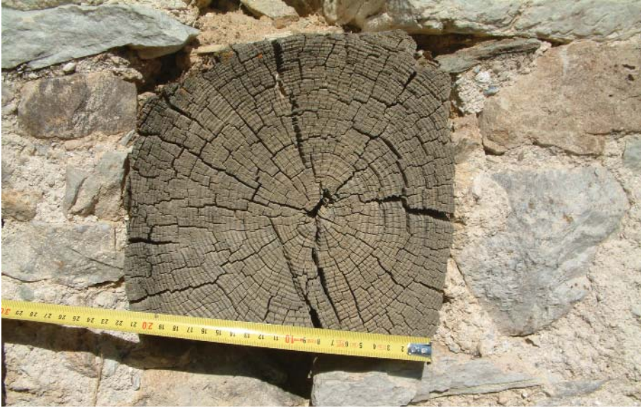
Fig. 1. Frabosa Soprana, località Casera Vecchia, trave di larice datato al 1632 (dendrocronologia)
