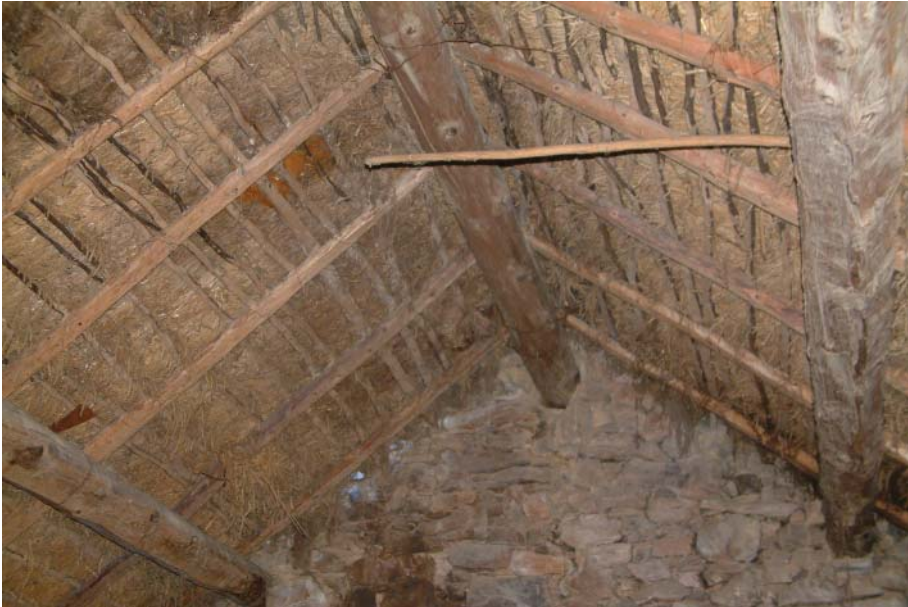
Fig. 9. Frabosa Soprana, località Casera Vecchia, struttura lignea del tetto e resti del manto in paglia lunga di segale
