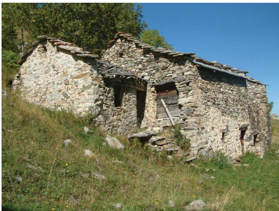
Fig. 8. Frabosa Soprana, località Casera Vecchia, stalla-fienile con annesso casòt
