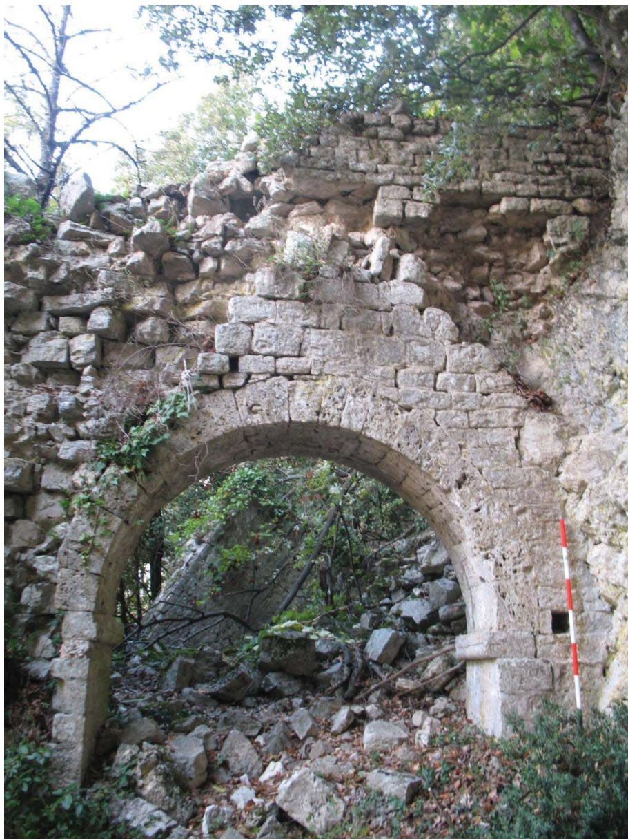
Fig. 13. San Benedetto de cripta Saxi Latronis , arco d'ingresso alla chiesa CF 2
