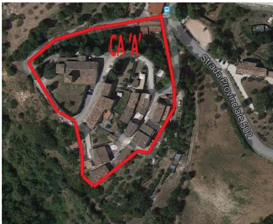
Fig. 6. Borgiano, veduta satellitare con indicazione del Complesso Architettonico "A", da Google Earth
