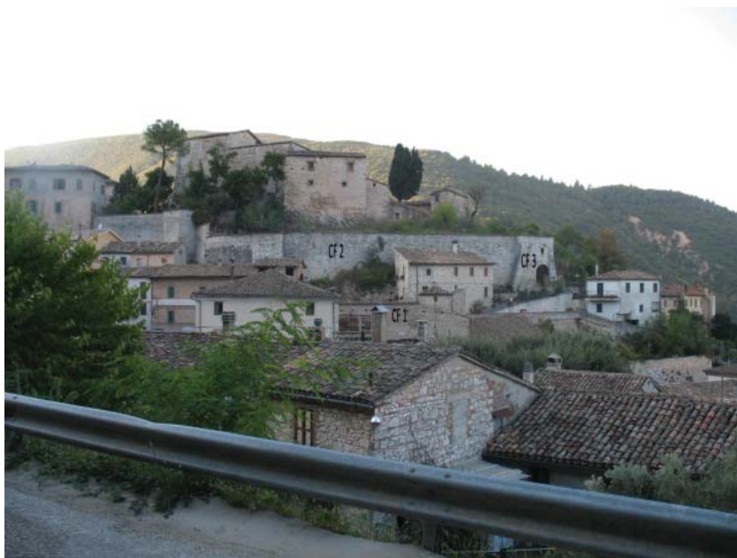
Fig. 8. Serrapetrona, veduta generale dell'insediamento fortificato. Si notano il ridotto fortificato superiore, la cinta muraria interna CF 2 con porta di accesso CF 3 e la seconda cinta muraria CF 1
