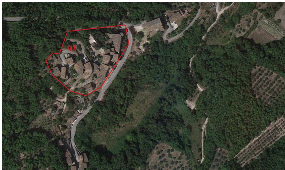
Fig. 5. Vestignano, veduta satellitare con indicazione del Complesso Architettonico "A", da Google Earth
