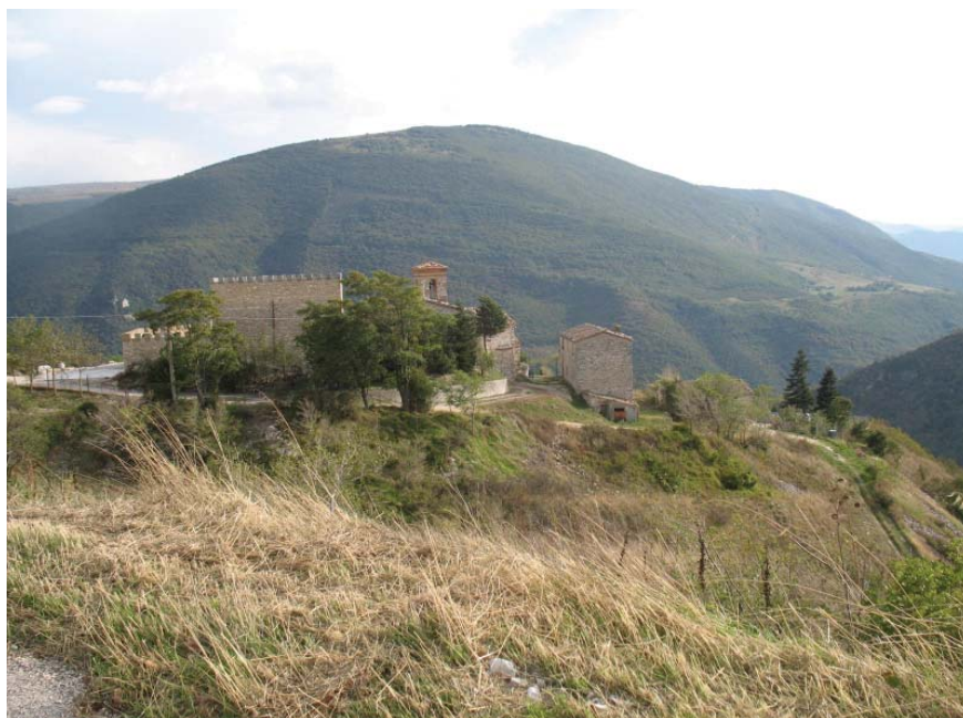
Fig. 3. Statte, veduta generale del piccolo insediamento fortificato. Alla base del pianoro si riconoscono piani artificiali probabilmente riconducibili al percorso dell'antico fossato difensivo
