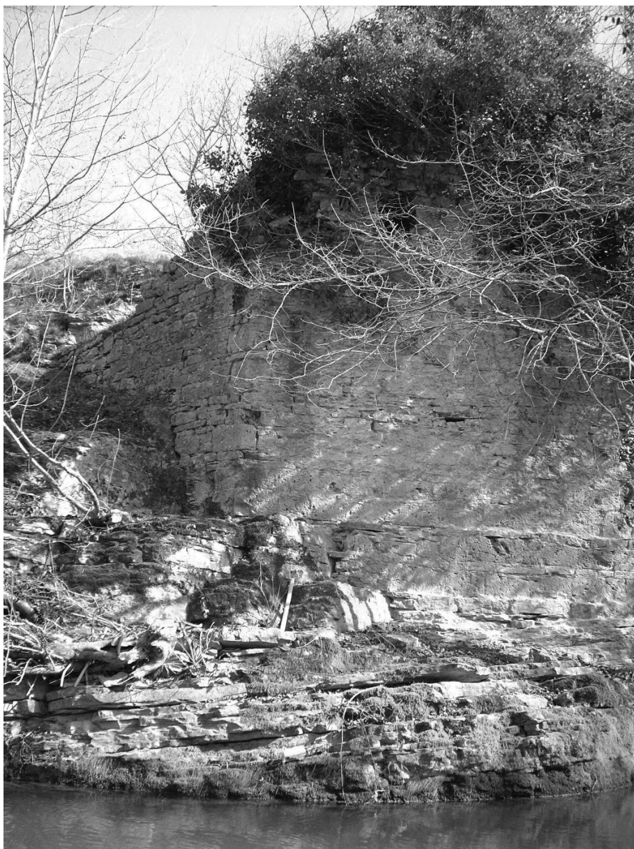
Fig. 15. Ponte di Bistocco, veduta generale dell'imposta dell'arcata conservata
