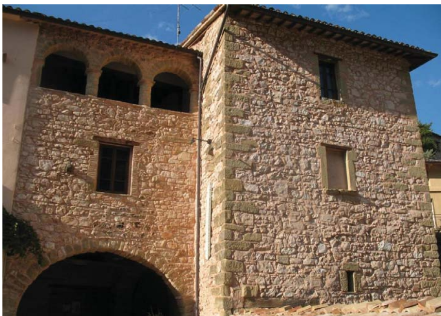
Fig. 10. Serrapetrona, l'edificio su due piani con loggetta superiore restaurato CA "C"
