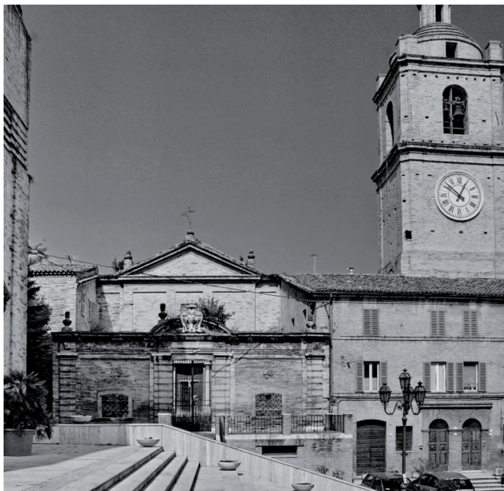
Fig. 5. Porto San Giorgio, ingresso e campanile del Cimitero di S. Giorgio, arch. Giuseppe Lucatelli, 1815 ca. (foto F. Mariano)
