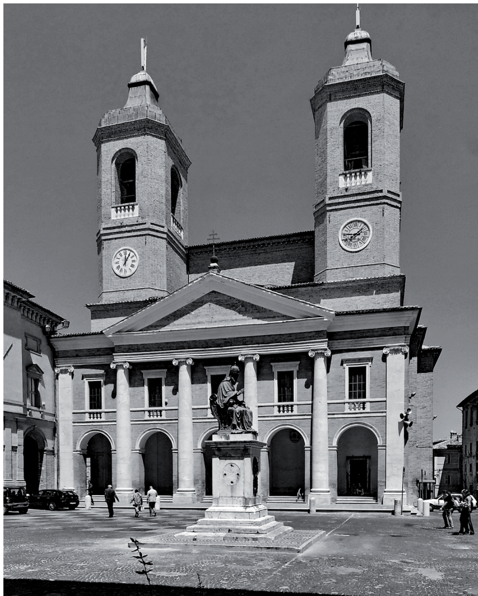
Fig. 19. Camerino, Cattedrale della SS. Annunziata, facciata, arch. Andrea Vici, arch. Clemente Folchi Vici, 1806-23 (foto F. Mariano)
