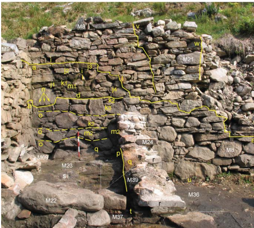
Fig. 3. Analisi muraria del settore del forno di affinazione
