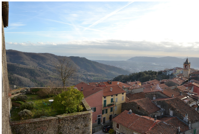
Fig. 17. Vista verso il bastione delle aromatiche e verso il borgo
