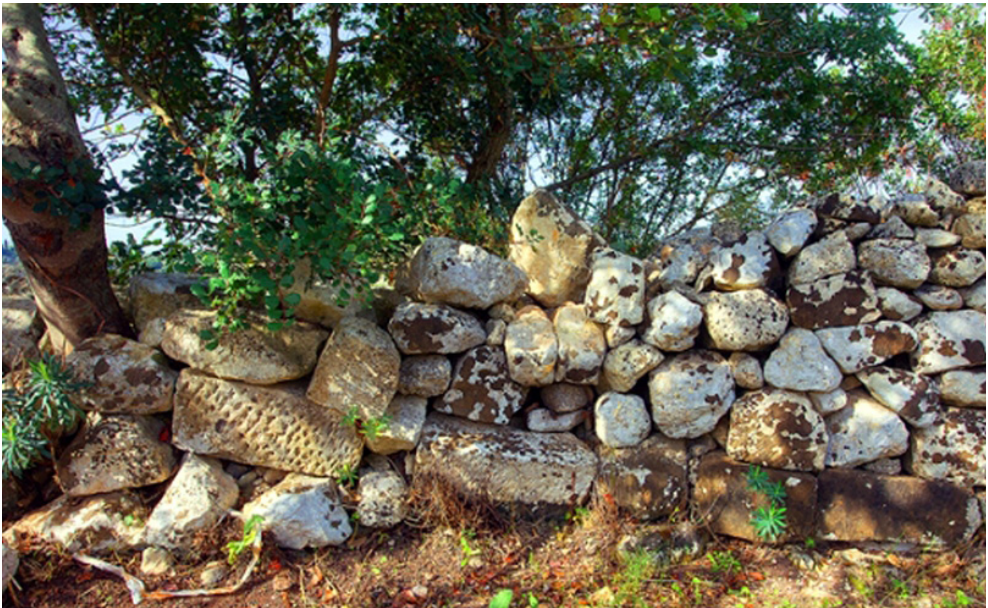
Fig. 6. Castel di Lega di Ferla: muro a secco con conci squadri di riempimento (foto di D. Barucco)
